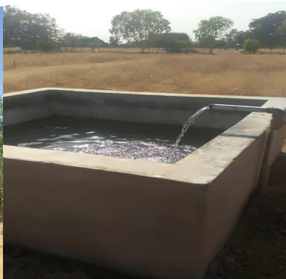
Vue du bassin de stockage
