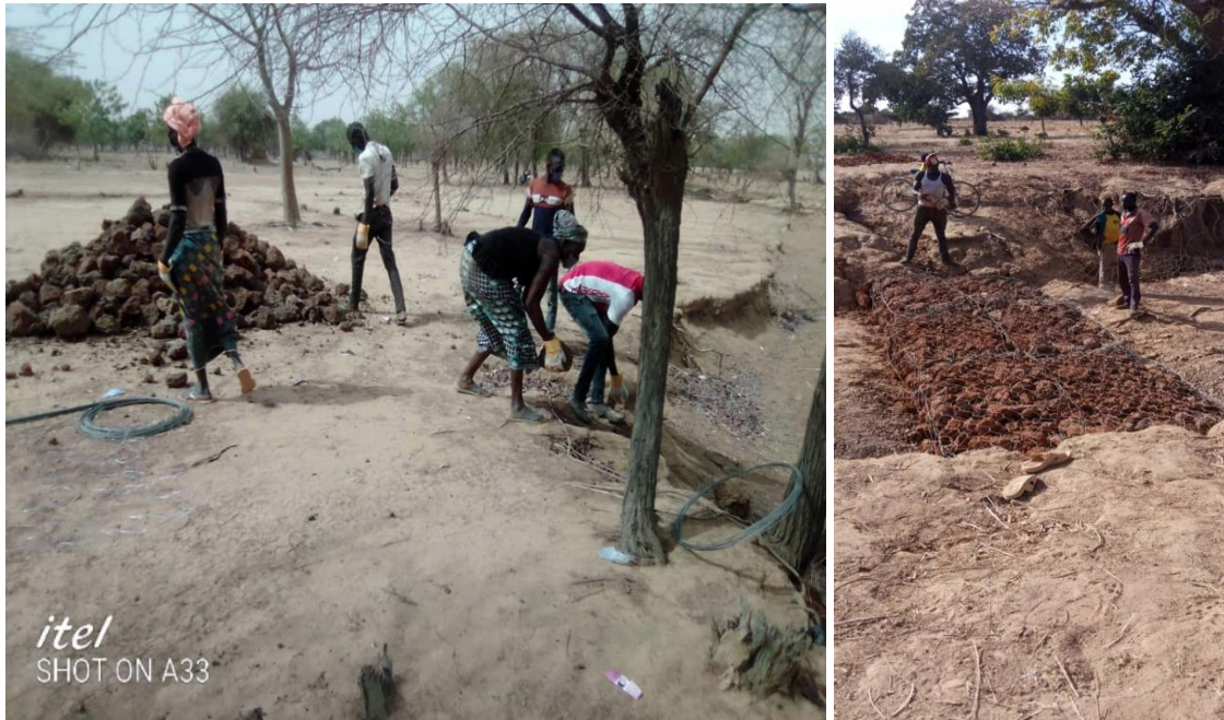
PHOTO 14 : Site identifié pour le traitement de ravine dans la commune de Zéguédéguin et vu de l'ouvrage
