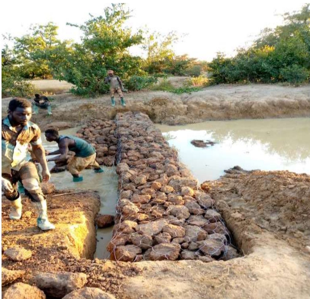
Photo 12 : Piège à sédiments Sidikompenga
