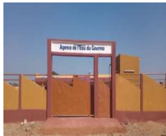
Photo 7 : Entrée principale du siège
