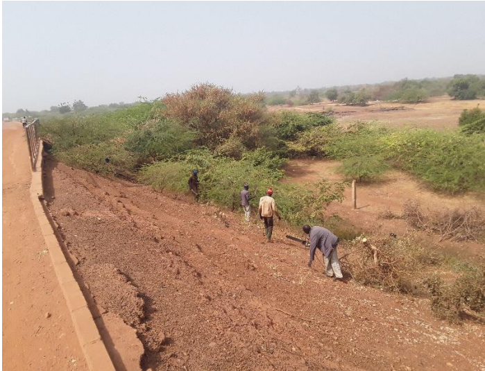
Photo 5 : Destruction des arbres et arbustes sur les talus du barrage de Sidikompenga à Bilanga
