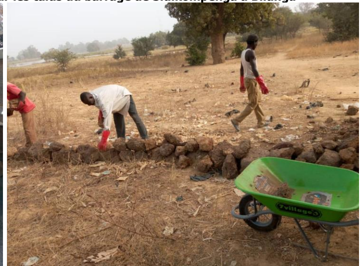
Photo 6 : Collecte et pose de moellons pour la réalisation des cordons pierreux sur les berges du barrage de Boudiéri par le CLE Dyamon'Siiga
