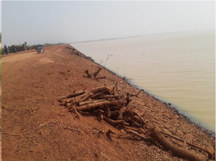
Photo 5 : Destruction des arbres et arbustes sur les talus du barrage de Sidikompenga à Bilanga
