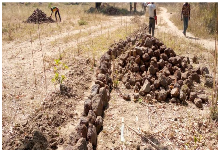
Photo 2 : Réalisation de cordon pierreux autour du barrage de la Tapoa par le CLE Tapoa Gnima
