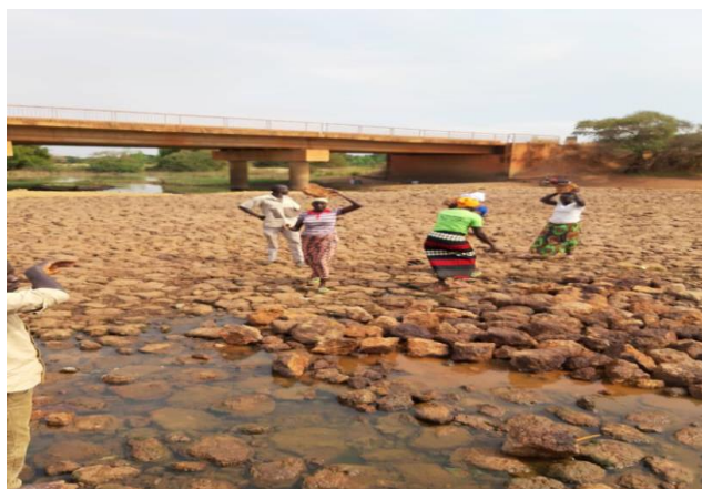
Photo 1 : Rechargement du bassin de dissipation du barrage de la Tapoa par le CLE Tapoa Gnima
