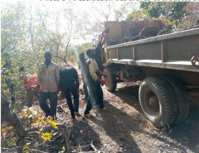
Photo 6 : Collecte et pose de moellons pour la réalisation des cordons pierreux sur les berges du barrage de Boudiéri par le CLE Dyamon'Siiga
