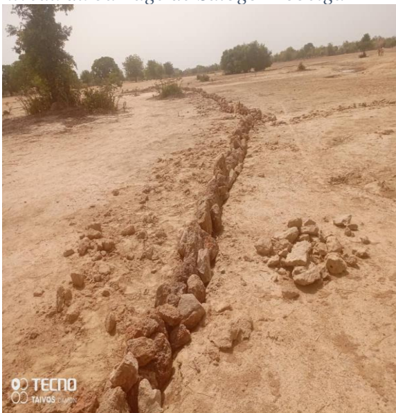
Photo 5 : Cordons pierreux réalisés au niveau du barrage de Salogo-Mobeiga
