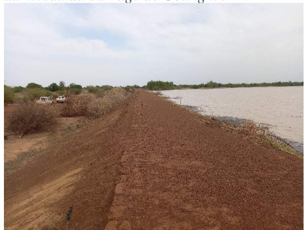
Photo 4 : Membres Piège à sédiments réalisé au niveau du barrage de Gounghin
