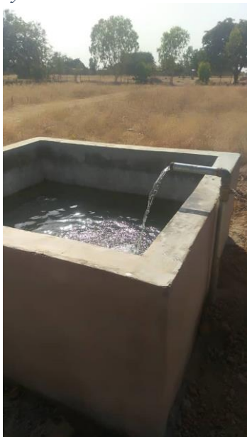
Photo 15 : Vue du bassin de stockage
