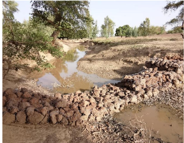
Photo 4 : Membres Piège à sédiments réalisé au niveau du barrage de Gounghin
