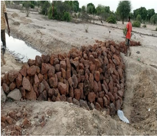
Photo 3 : Piège à sédiment réalisé au niveau du barrage de Salogo-Mobeiga
