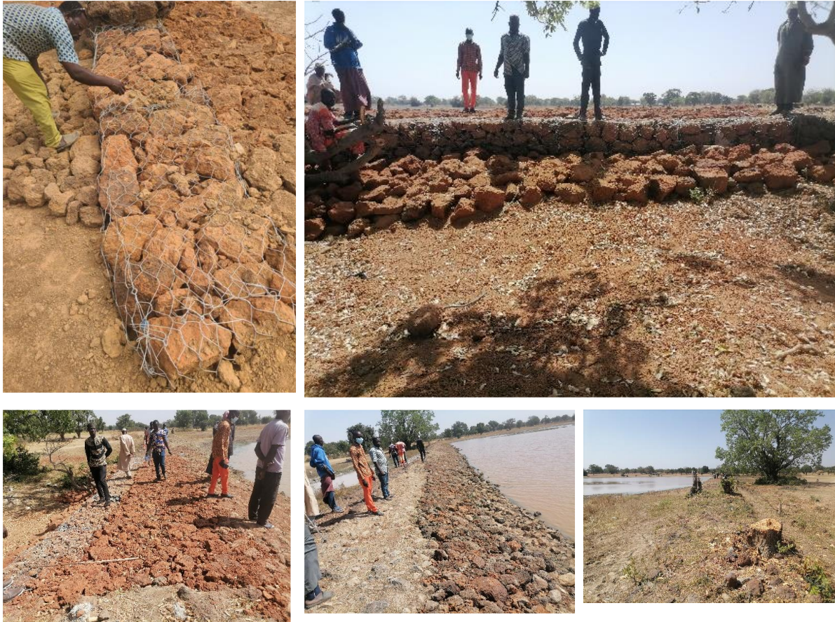
Photo 19 : Travaux de renforcement de la digue du barrage de Souka
