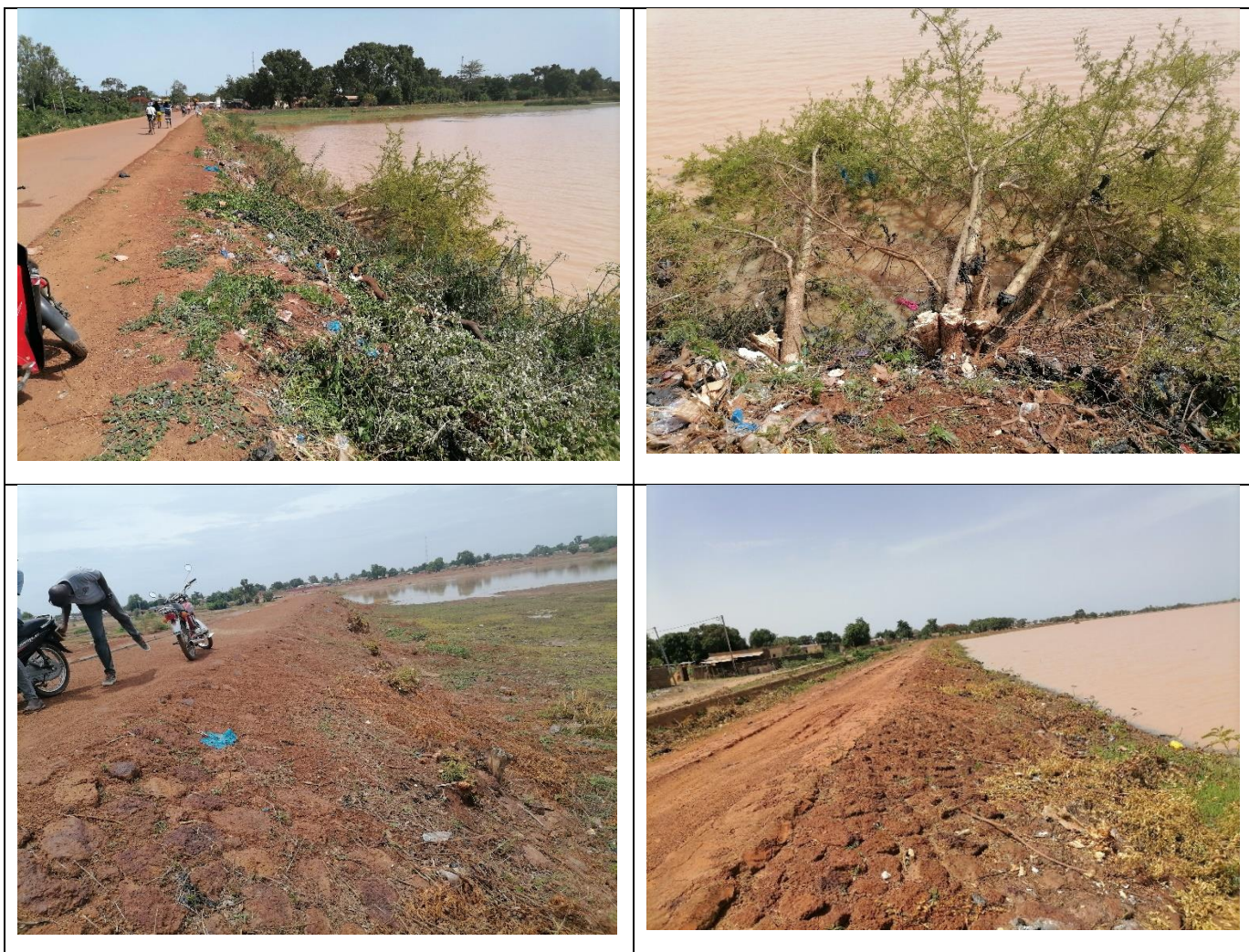
Photo 8 : Nettoyage des digues des barrage N°1 et 2 de Fada N’Gourma
