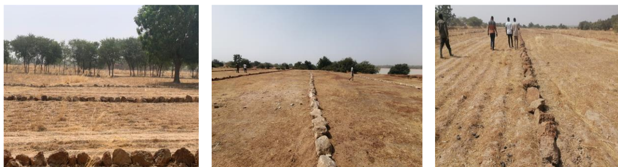
Photo 9 : Illustration photographique de la réalisation des cordons pierreux sur les berges des barrages de Lorgho, Lantaogo et Pampangou
