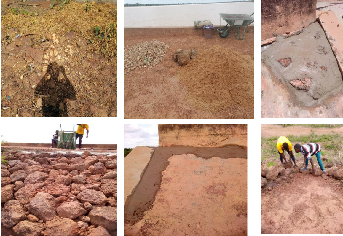
Photo 10 : Illustration photographique des travaux d'entretien courant du barrage de Zanré
